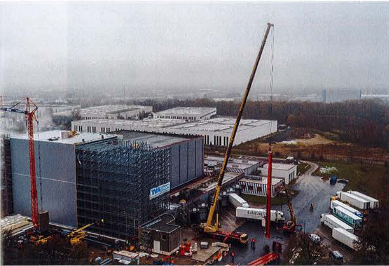
Einbringung der Regalbediengeräte.
