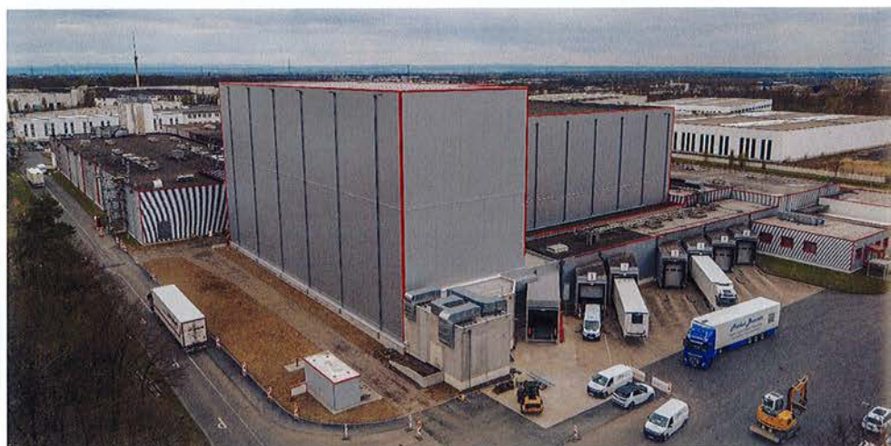
Luftbild des fertiggestellten Projektes
