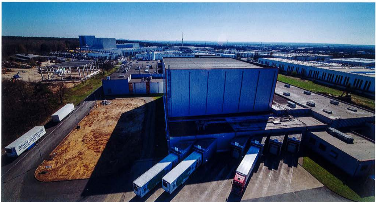
Die Ausgangssituation zeigt das Baufeld Neubau TK-HRL 2
